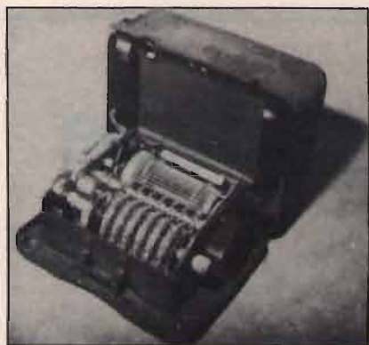
foto 4 L'interno della M-209.
